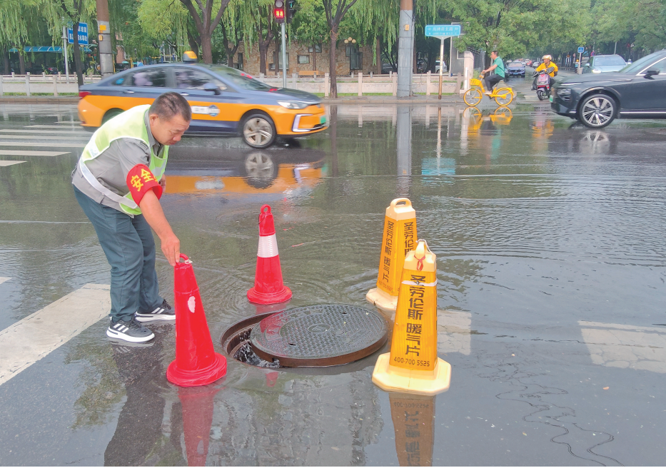
工作人员在隐患路段并盖处布设警示锥桶。
