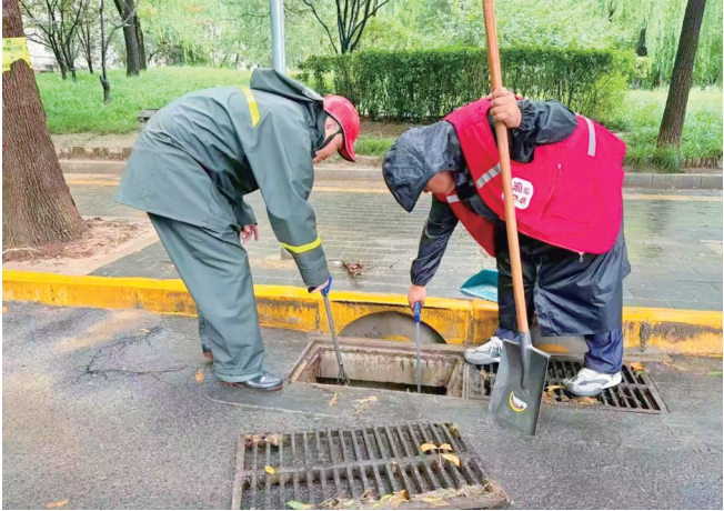
▲大屯街道工作人员清掏雨水箅子。
