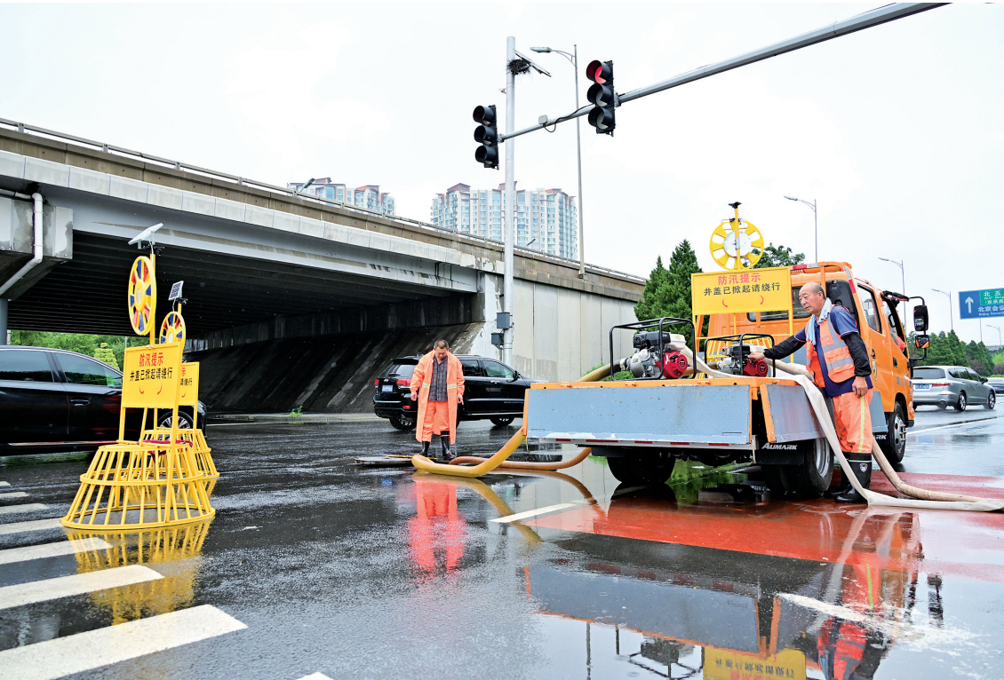
▲奥运村街道在北五环辅路仰山桥进行应急排水作业。
