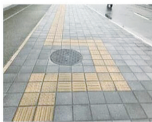
1.盲道绕行井盖
