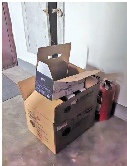
楼道堆物堆积，存在安全隐患。
